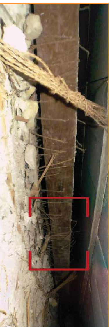
VISTA DEL INTERIOR DEL FALSO TECHO DESDE PUNTO P2.
